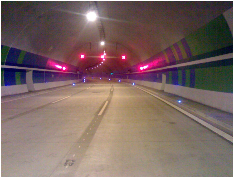
Obrázek 10 - Použití vodících trvale svítících knoflíků v tunelu
