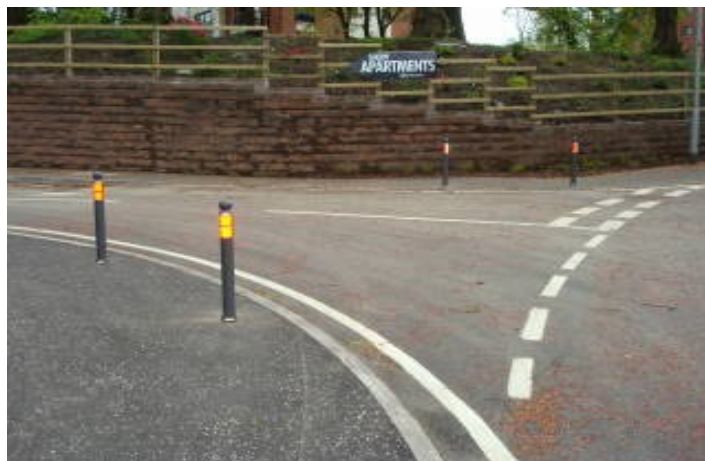
Obrázek 3 - Příklad umístění zvýrazňujících sloupků
