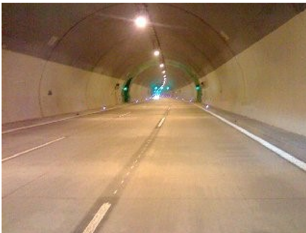
Obrázek 9 - Použití vodících trvale svítících knoflíků v tunelu
